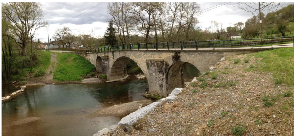
Fig. 32. Pont de César
