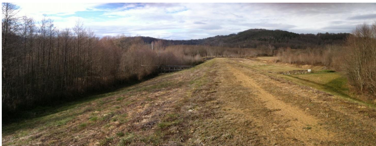
Fig. 10. Barrage écrêteur de crues des Mielles
