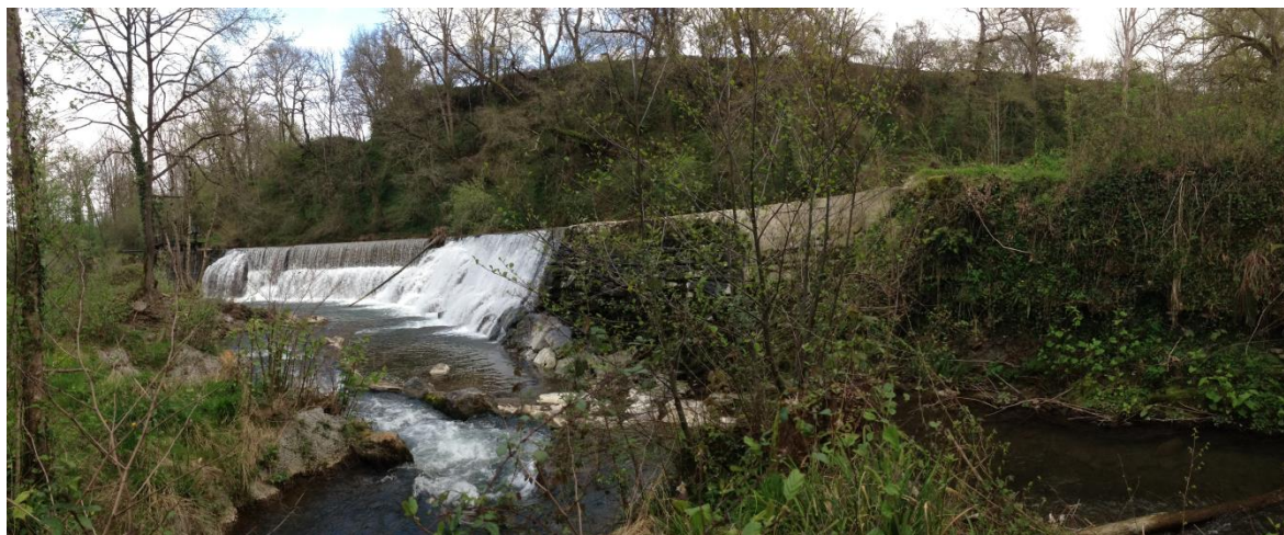
Fig. 33. Seuil d'alimentation de la centrale électrique Bessonneau
